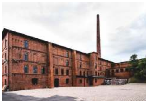
Cegielnia „Budy” w Ostrzeszowie
