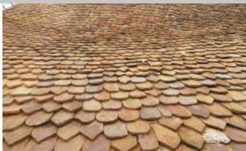
Fot. 3. Oryginalne pokrycie dachu Domu Solnego w Lubaniu zachowane in situ. Fot. M. Gąsior
