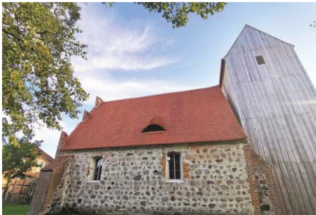
Kościół w Rossow, Niemcy – odtworzona przy użyciu nowej dachówki połać dachu. Fot. Tomasz Nieruchalski – Heritage Roof Tiles Sp. z o.o.
