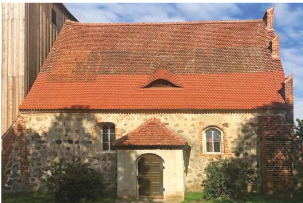
Kościół w Rossow, Niemcy po zakończonej renowacji dachu. Fot. Tomasz Nieruchalski – Heritage Roof Tiles Sp. z o.o.
