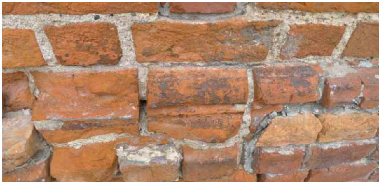
Północna elewacja prezbiterium, relikw profilowanego gzymsu cokołowego (faza III), fot. M. Małachowicz
